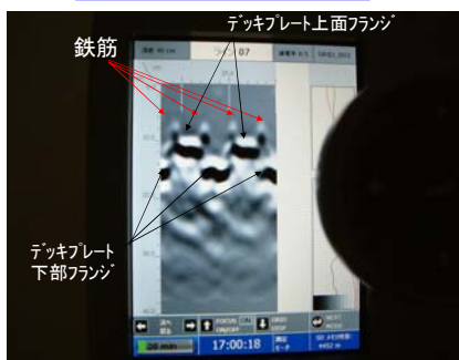
断面画像(ライン7)の2D断面画像 ※ 4本の鉄筋とデッキPの上下フランジが表
